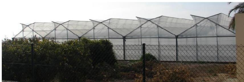
Un invernadero en condiciones de clima valles debe tener una altura lateral al menos de 3.0m mientras que en zonas cálidas altura lateral mínima 3.5m para garantizar mayor ventilación y renovación del aire dentro del invernadero.
