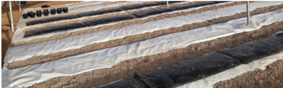
Los canales de drenaje deben tener una pendiente de 0.5 a 1.0% para salida del agua, exceso de drenaje.
